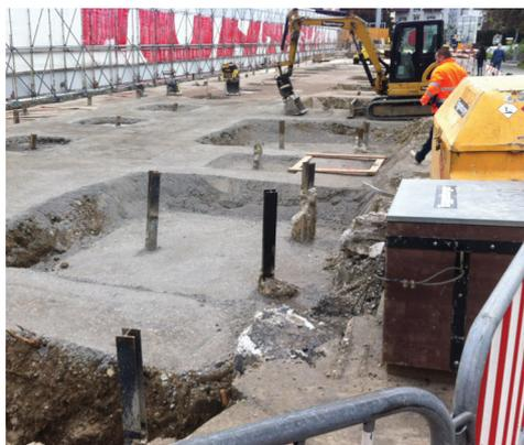
Bodenplattenvertiefungen mit Injektionsrammpfählen
