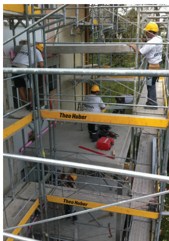
Versetzen der neuen Balkone mit Pneukran
