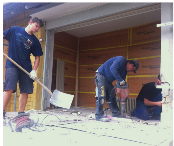
Ein neuer Ausgang auf den Balkon entsteht
