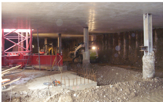
Hofkelleraushub unter der Betondecke
